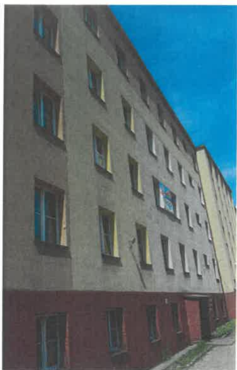
Fot. 1 - Widok budynku.
